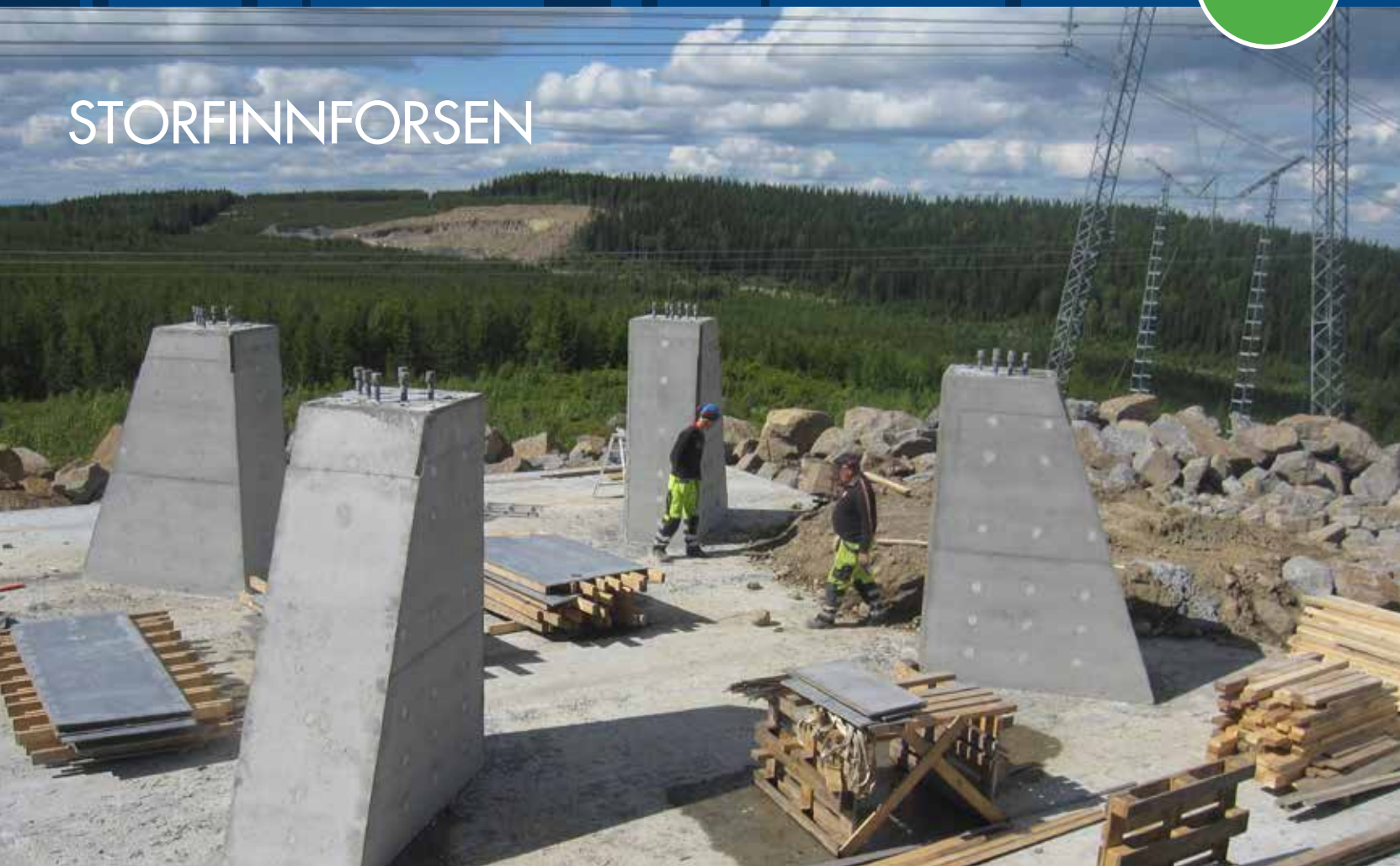
Gjutning av betongfundament till kraftledningar från vindkraftspark.
