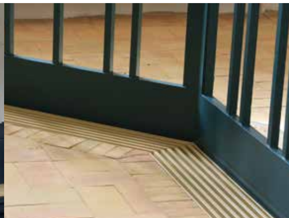
I Paarup Kirke er Meinertz-konvektorer placeret diskret rundt om knæfaldet under en Meinertz ProLine Rist.
