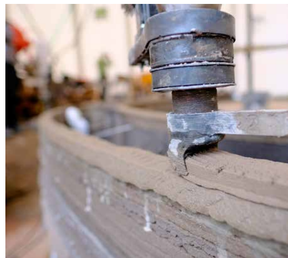
3D-printeren i gang med at opføre kontorhotellet The BOD på Nordhavn – den første bygning i Europa, som er opført med 3D-teknologi og lever op til alle standarder.
