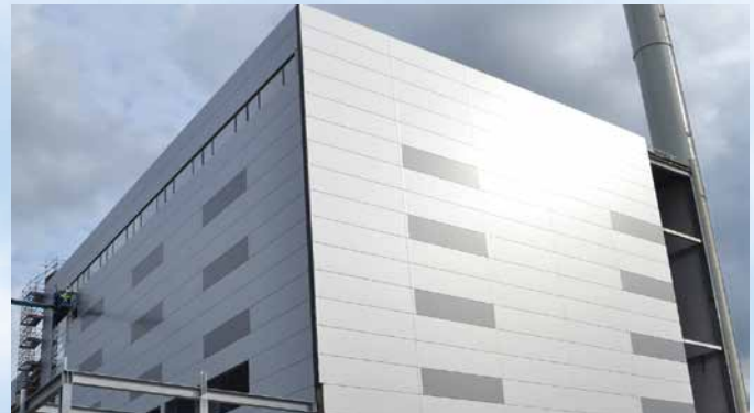
Enexio har leveret en rekordstor absorptionsvarmepumpe til det nye biomasseværk i Horsens. Varmepumpen køler røggassen helt ned til 10°C.
